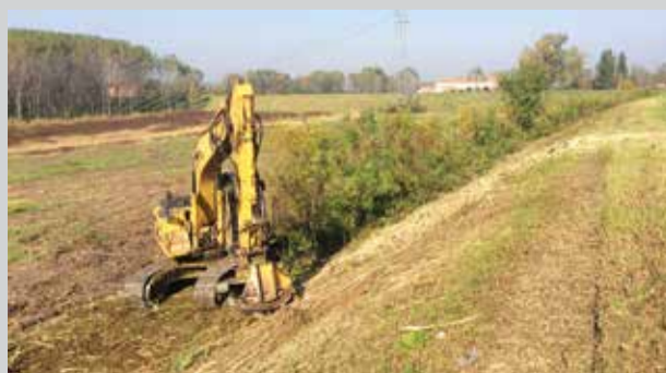
➤ Manutenzione degli argini a Luzzara
