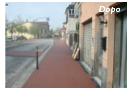
Il centro di Codisotto prima e dopo i lavori di riqualificazione
